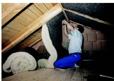
Na-isoleren bestaande bouw
