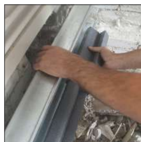
Aanbrengen thermostrip
