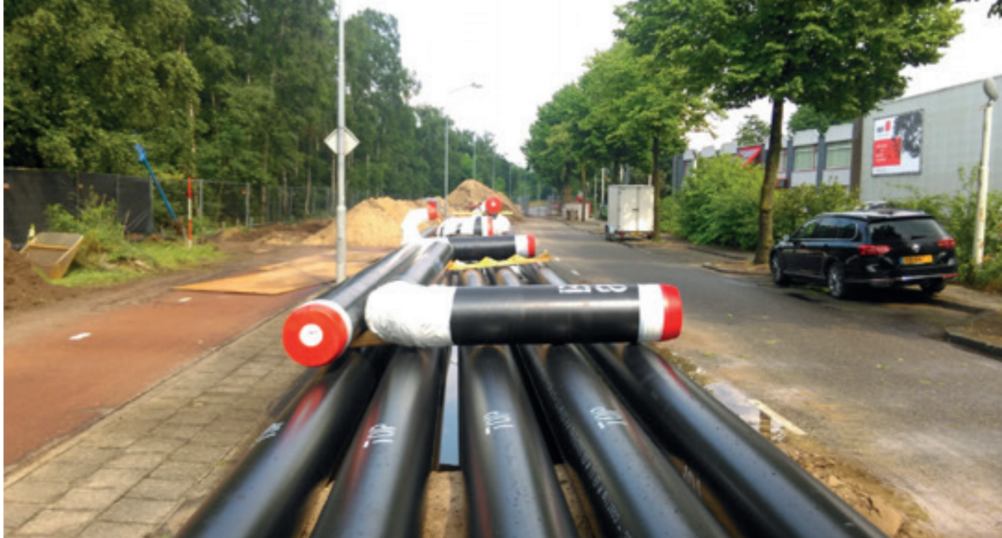
Aanleg van warmtenet (foto: Warmtebedrijf Ede)
