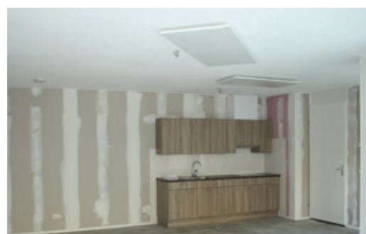
LAVA® BASIC-DM 1000 W gebruikt bij renovatie van appartementen
