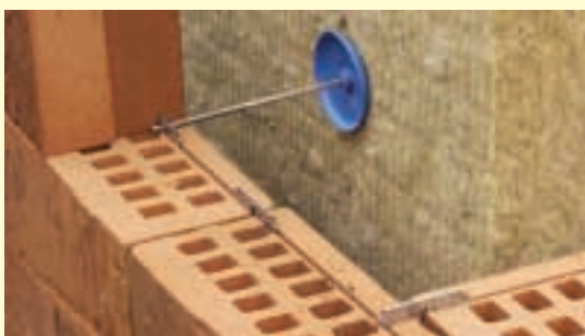
Positie van RVS-clip en spouwanker in een Daas ClickBrick® gevel
