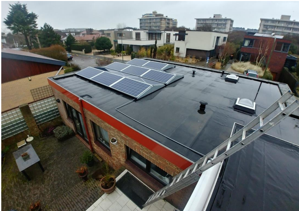
Inmeten van het dak
