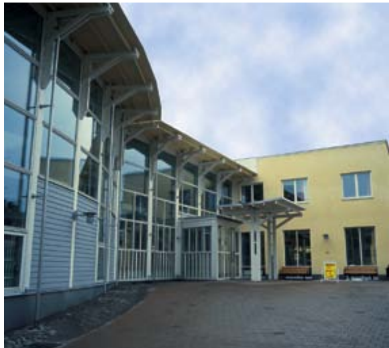
FLOORMATE toegepast in bedrijfsruimte
