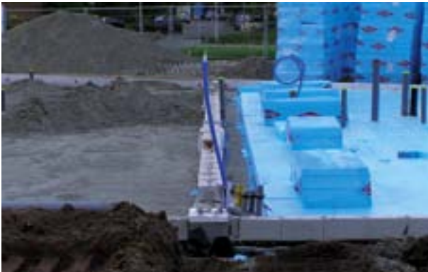
Vloerisolatie direct op de grond
