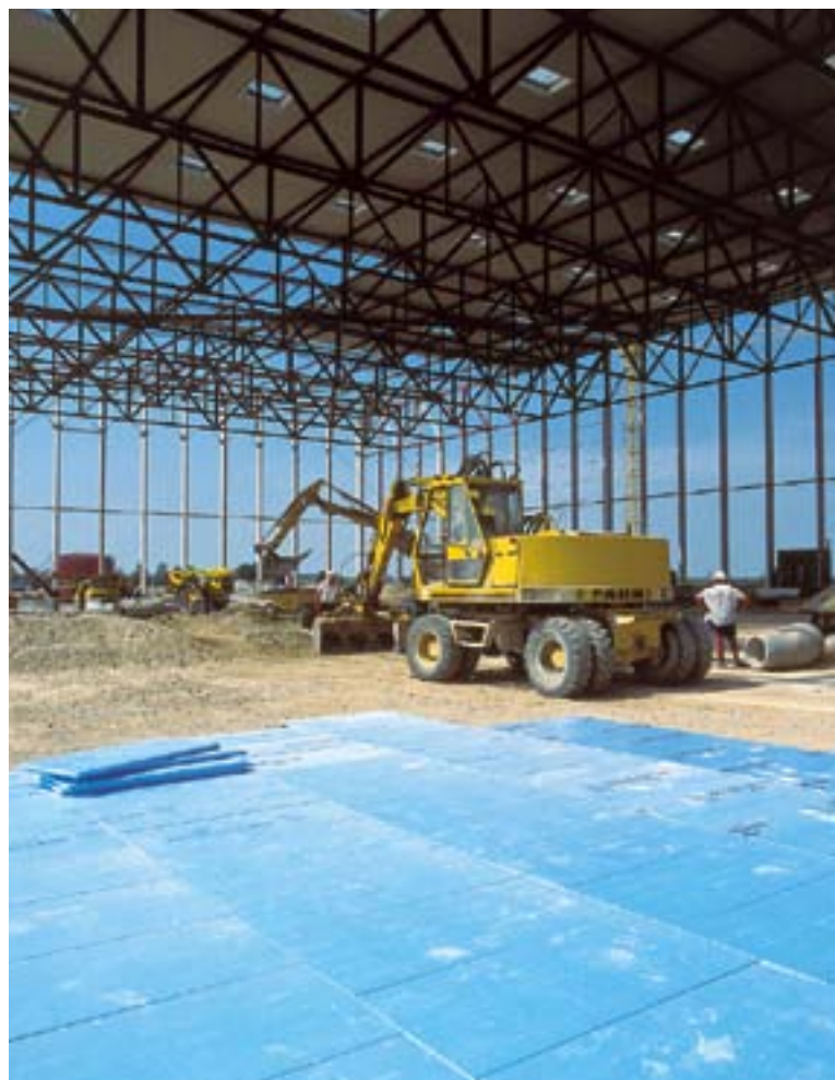
Isolatie onder de draagvloer
