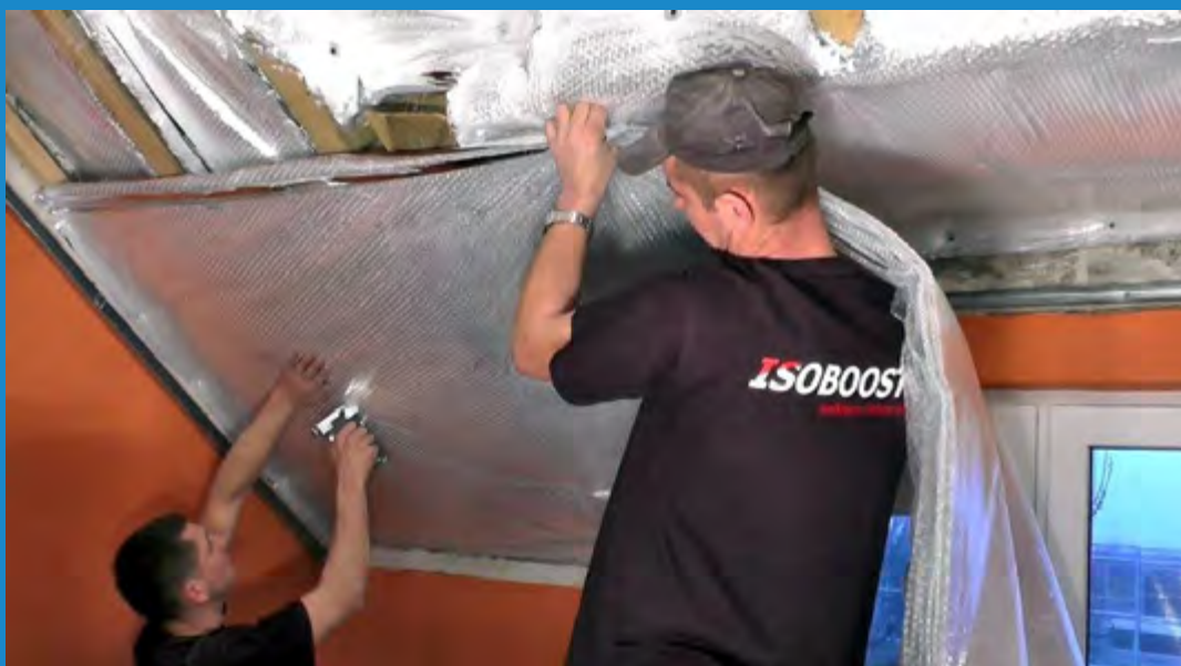
Foto 4. ISOBOOSTER is hier strak tegen zolder dak gezet.
