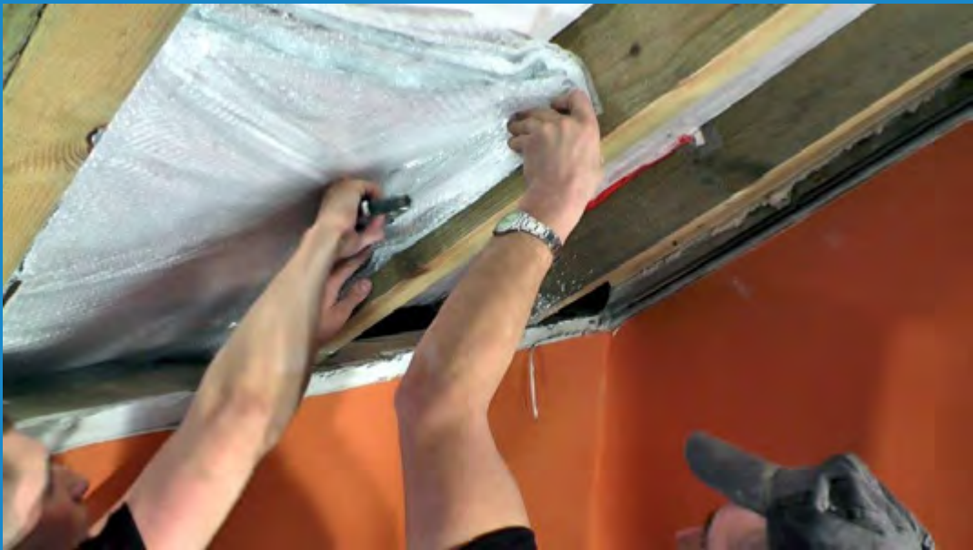
Foto 1. Rand aan zijkant rol omslaan en vastzetten, met nieten.
