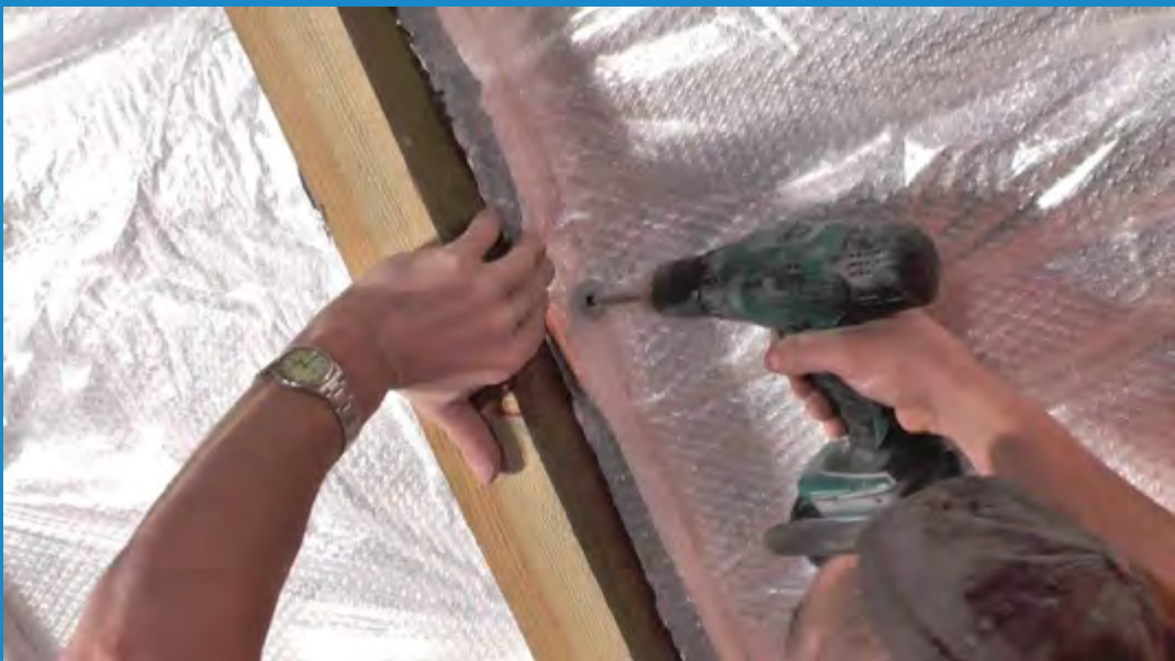
Foto 2. Rand vastzetten met een rozet / ring met grote buitendiameter.
