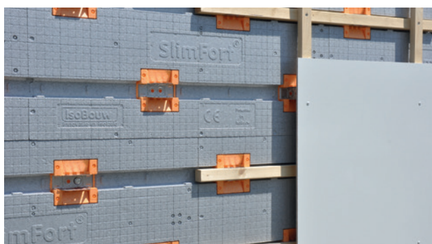
Afwerking met vezelcementplaten
