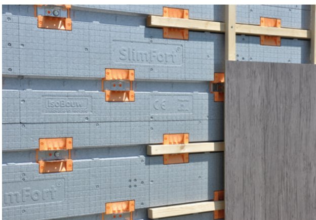
Afwerking met geperste minerale wol platen
