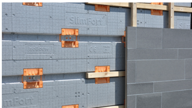
Afwerking met tegels
