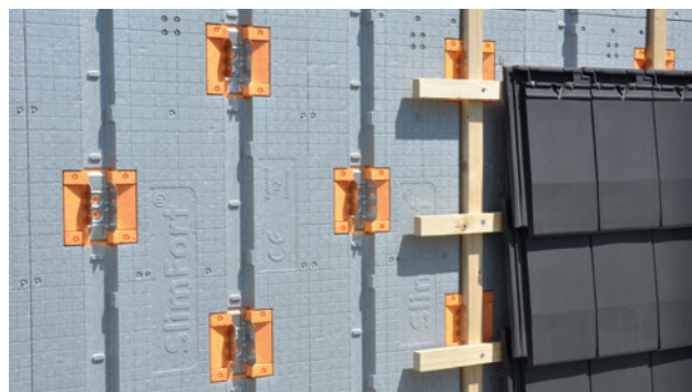
Afwerking met pannen
