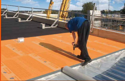
plat dak isolatie
