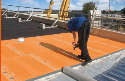
plat dak isolatie
