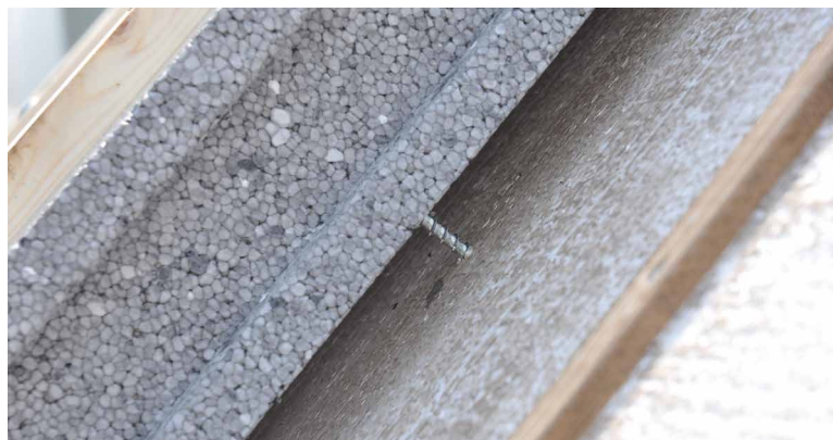
Speciale schroeven zorgen voor een constructief sterke, vrijdragende constructie
