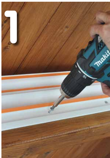
Randprofiel vastschroeven = luchtdichtheid
