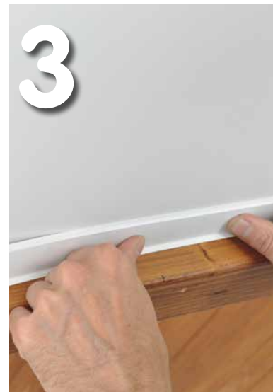
Klikprofiel bevestigen = esthetische afwerking
