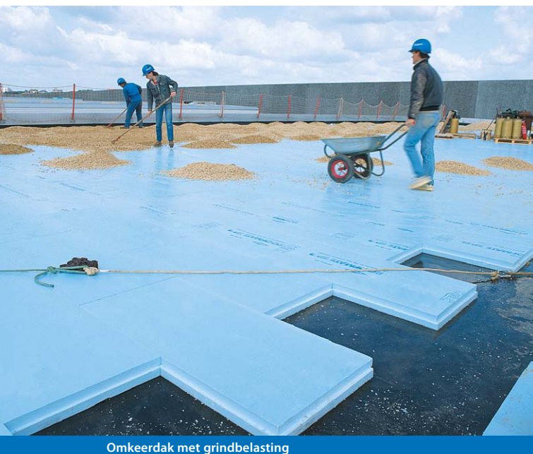
Omkeerdak met grindbelasting
