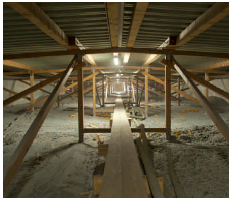
Beste verhouding prijs/prestatie: open opblazen op het plafond van de bovenste verdieping
